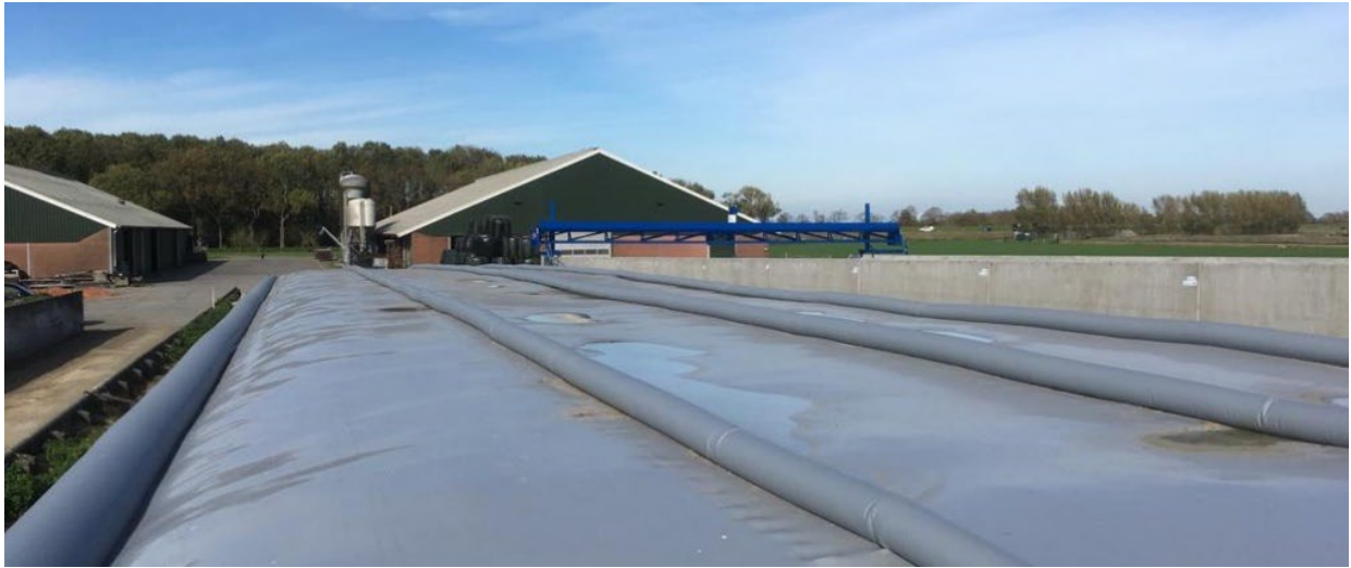
Figuur 22: Een sleufsilo afgedekt met een kuilkleed met waterslangen (Kernet Beton Balk, 2021)
