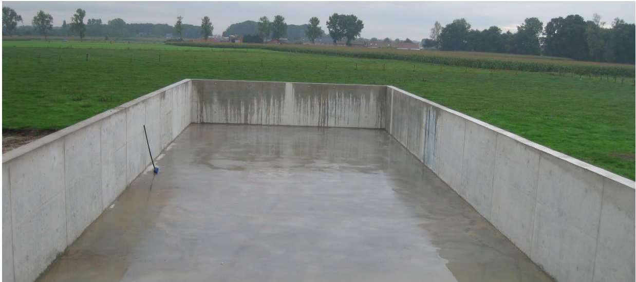
Figuur 28: Sleufsilo met een silovloer uit gestort beton met rechtopstaande wanden uit prefab betonelementen (Drejaco, 2021)
