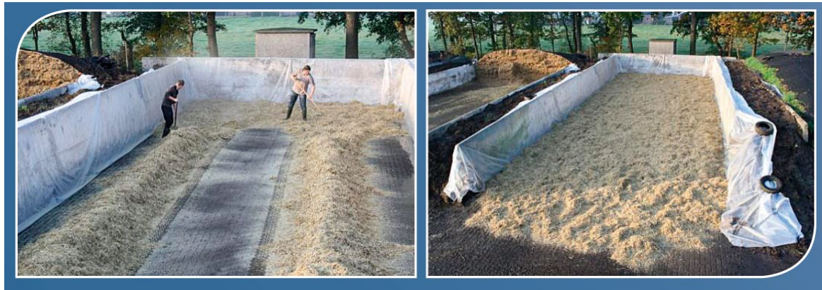
Figuur 19: Het gebruik van een absorberende onderlaag van stro in een sleufsilo (Broos Water, 2012)
