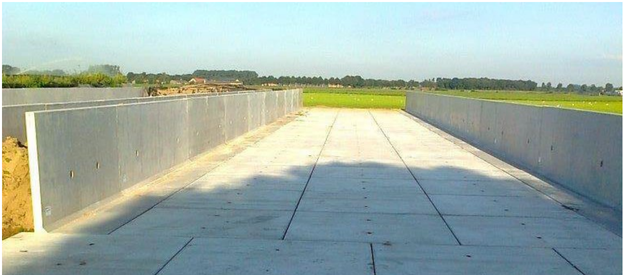
Figuur 29: Sleufsilo met vloer en wanden uit prefab betonelementen (MBS Beton, 2020)
