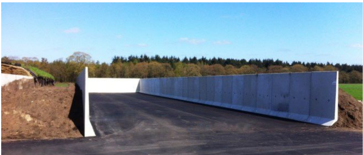
Figuur 30: Sleufsilo met asfaltverharding en wanden uit prefab betonelementen (MBS beton, 2016)
