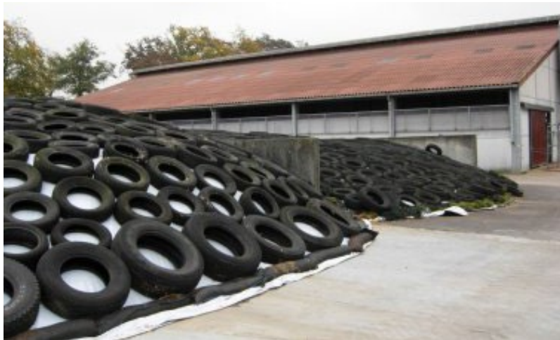
Figuur 20: Een sleufsilo met autobanden als afdekmiddel (Boerenbond, 2018)
