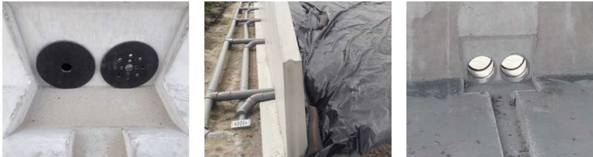
Figuur 34: Sleufsilo met zijwaartse afvoerpunten voor erssappen met een dubbele afvoergoot en verwisselbare deksels (Dam Beton, 2021)
