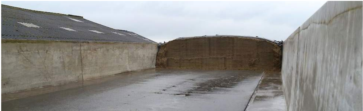
Figuur 13: Glad en vast snijvlak bij de opslag van organisch materiaal in een sleufsilos (Melkvee, 2020)
