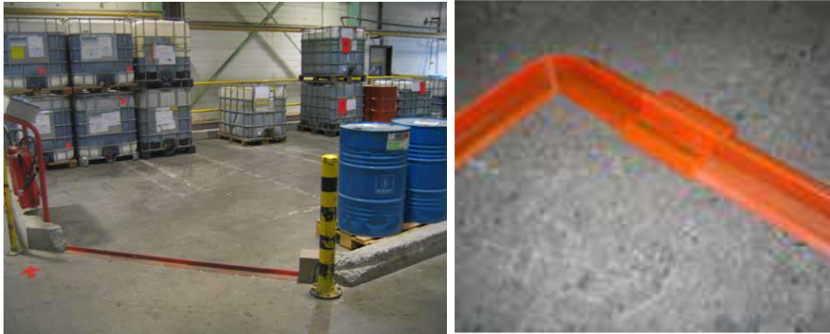
Figuur 49: Overrijdbare vloeistofdamp, type 'eco-barrier'. De bovenzijde is flexibel waardoor deze meeplooit wanneer er een voertuig overheen rijdt. (Bron: CGK)
