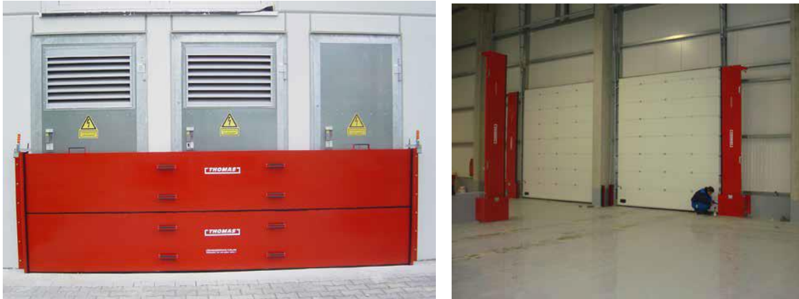
Figuur 48: Verschillende uitvoeringen van mobiele barrières (Bron: CGK).
