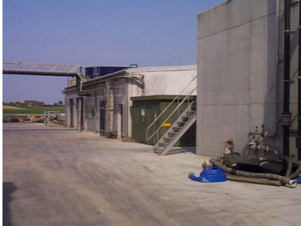
Figuur 2.5: Gebouw met de ultrafiltratie en de omgekeerde osmose
