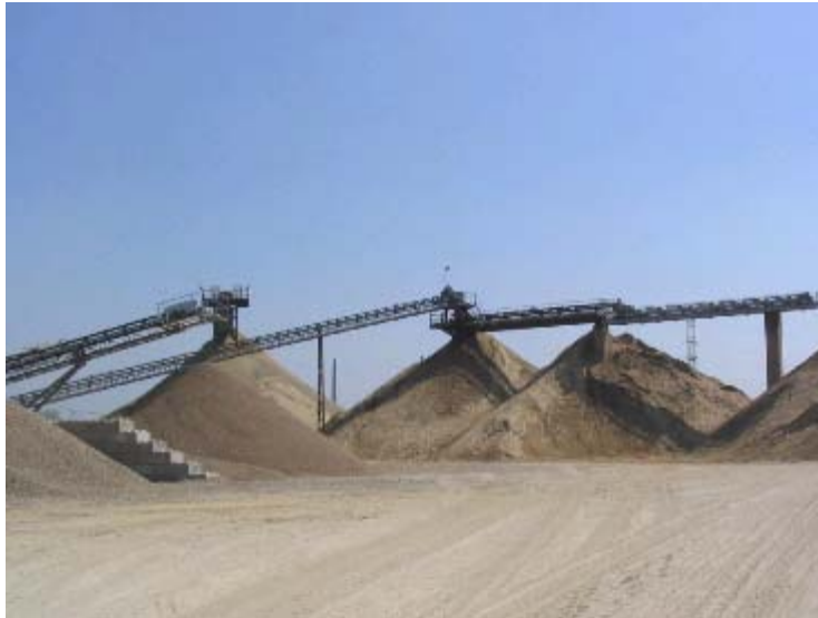
Figuur 13 : Opslag zand met transportbanden (Bron: Hanson)
