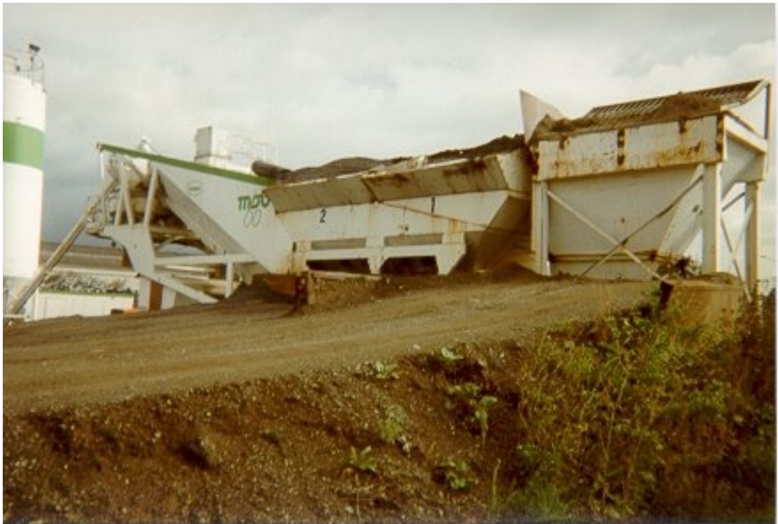
Figuur 46: Verplaatsbare Lambert centrale (linkerzijde)
