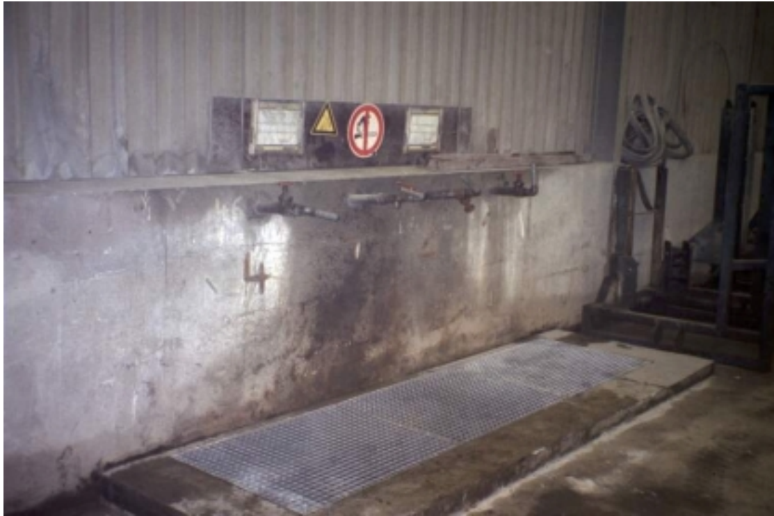
Figuur 24: Vulpunt met opvangbekken voor het vullen van flessen ontkistingsproducten
