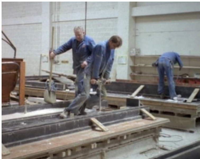
Figuur 27: Verdichten van beton met bekistingstrillers
