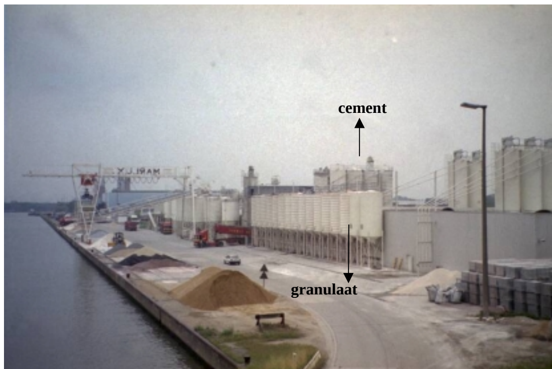
Figuur 17: Aanvoer van grondstoffen via water, tussentijdse opslag van zand en granulaten langs de kade en wachtsilo's aan het bedrijf.
