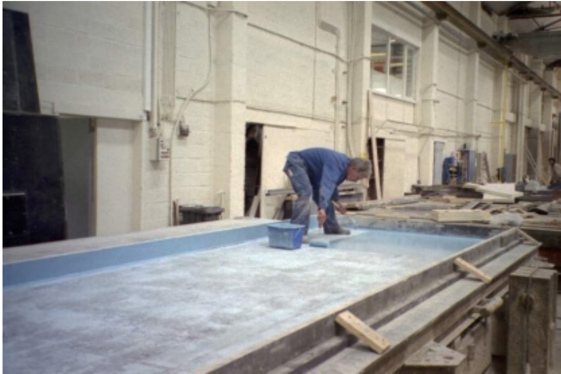
Figuur 25: Aanbrengen van bindingvertrager op de bekisting
