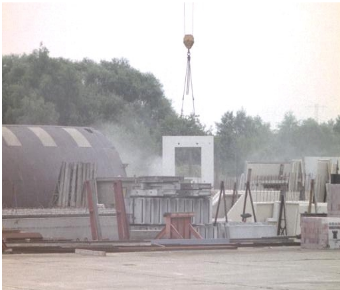
Figuur 29: Stofproductie bij zandstralen in open lucht van grote betonproducten
