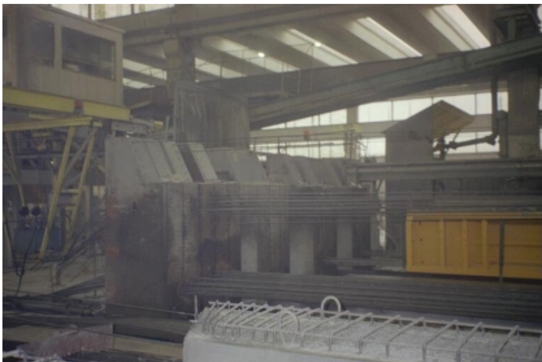
Figuur 26: Voorspankoppelen bij productie van voorgespannen beton.
