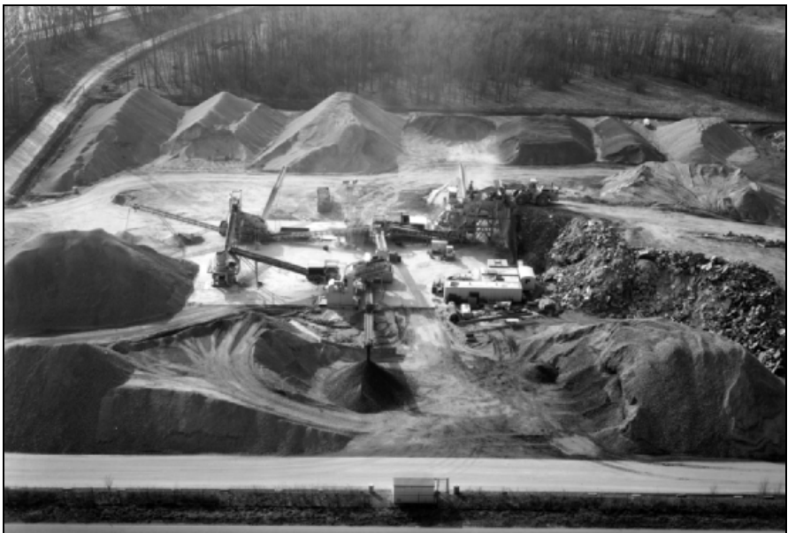
Figuur 15: Vaste breekinstallatie [Bron ARC]
