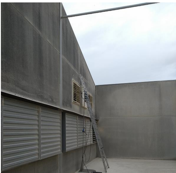
Figuur 1: voorbeeld van een stofbak bij lengteventilatie
