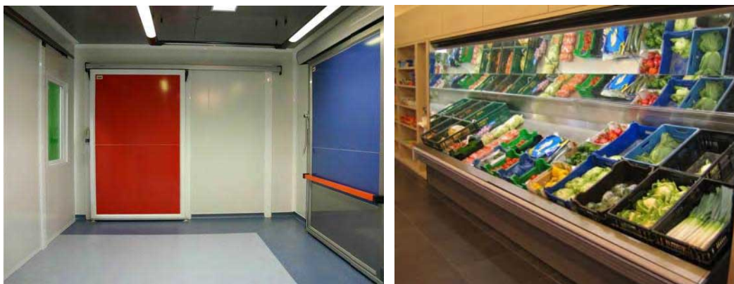
Figuur 176: Voorbeelden van proceskoeling: koelcel (links) en koeltoonbank (rechts)
