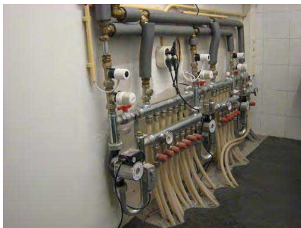
Figuur 202: Collector voor oppervlakteverwarming
