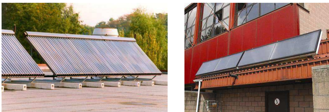
Figuur 5: Buiscollectoren (links) en vlakke plaatcollectoren (rechts)
