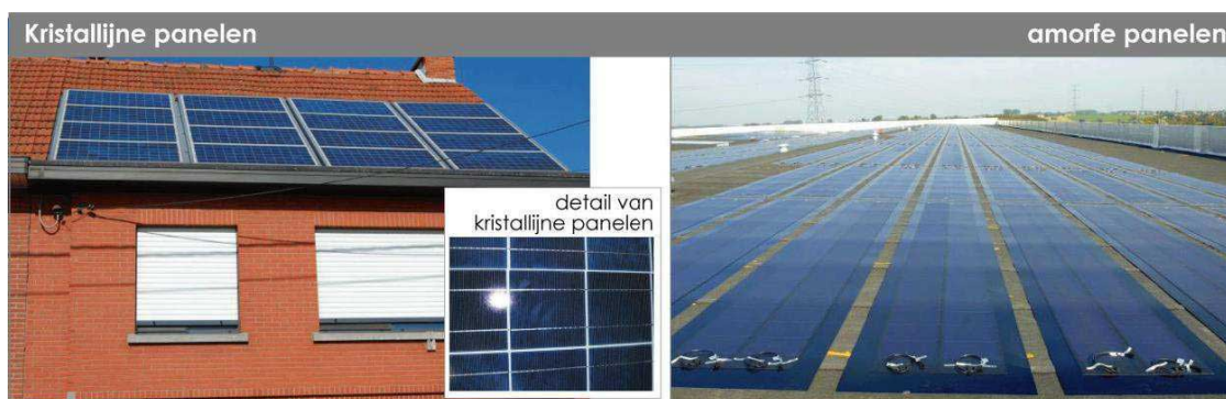
Figuur 9: Kristallijne panelen (links) en amorfe panelen (rechts)
