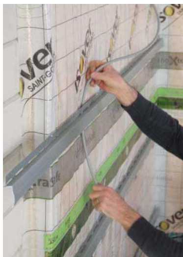
Figuur 9: Bevestiging van (metalen) stijl- en regelwerk Figuur 10: Doorvoeren van leidingen door leidingenspouw Figuur 11: Afwerkingsplaten op lattenstructuur
