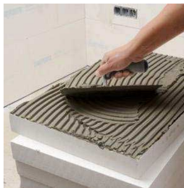
Figuur 8: Lijm op binnenisolatie
