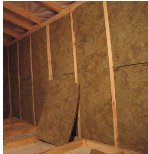
Figuur 6: Stijl- en regelwerk bij binnenisolatie: houten structuur
