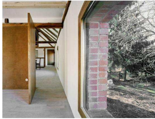
Figuur 4: Binnenisolatie afgewerkt met pleister
