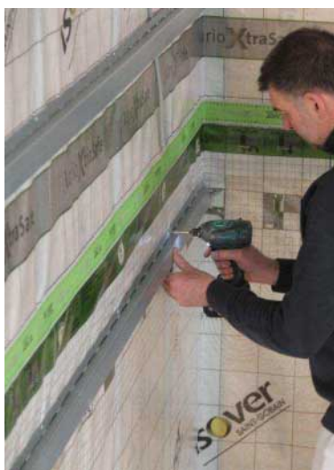
Figuur 9: Bevestiging van (metalen) stijl- en regelwerk Figuur 10: Doorvoeren van leidingen door leidingenspouw Figuur 11: Afwerkingsplaten op lattenstructuur
