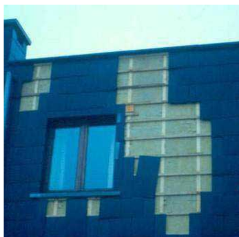
Figuur 16: Luchtlaag achter beplating
