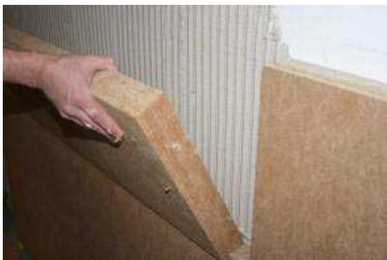
Figuur 7: Lijmen van binnenisolatie
