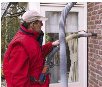
Figuur 24: Plaatsen van na-isolatie
