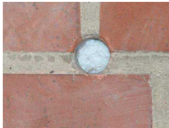
Figuur 19: Inblaasopening bij na-isolatie
