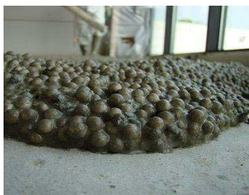
Figuur 26: Isolerende uitvullingslaag met EPS korrels
