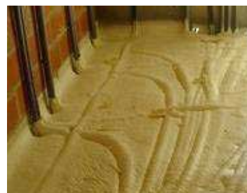
Figuur 27: PUR in situ
