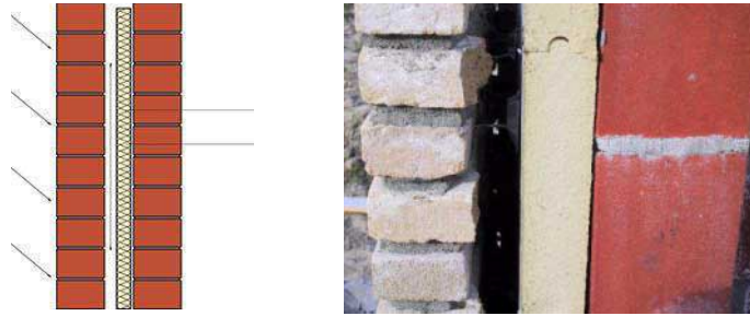
Figuur 17: Spouwmuur gedeeltelijk gevuld met isolatie
