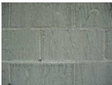
Figuur 21: Cellenbetonblokken van voor de jaren '80
