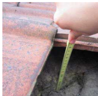
Figuur 32: Isolatie rechtstreeks onder dakpannen
