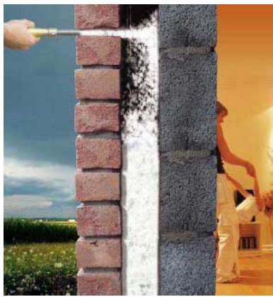
Figuur 18: Na-isoleren van traditionele spouw
