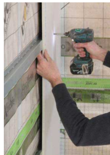
Figuur 9: Bevestiging van (metalen) stijl- en regelwerk Figuur 10: Doorvoeren van leidingen door leidingenspouw Figuur 11: Afwerkingsplaten op lattenstructuur
