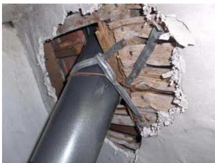
Figuur 31: Onafgewerkte doorvoeropening en
