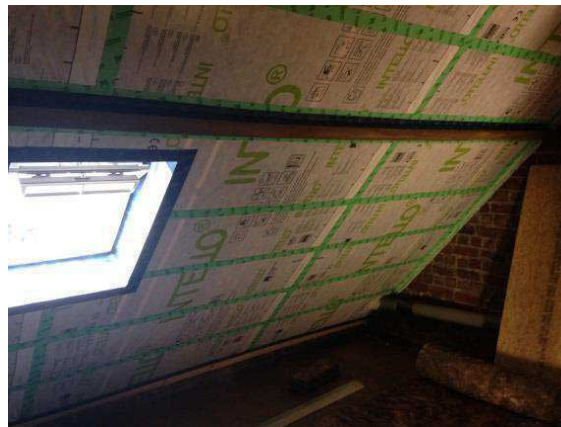
Figuur 25: Damp scherm bij een hellend dak
