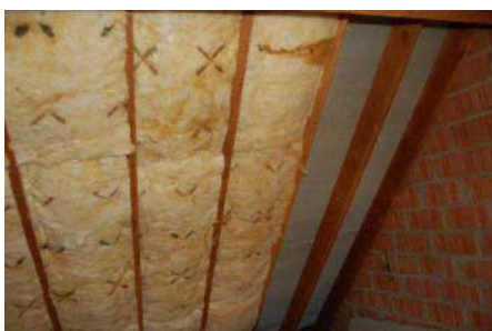
Figuur 33: Isolatie tussen de kepers
