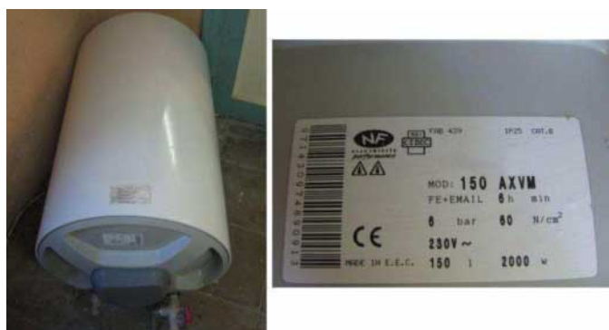
Figuur 5: Elektrisch voorraadvat met kenplaat met onder meer vermelding volume
