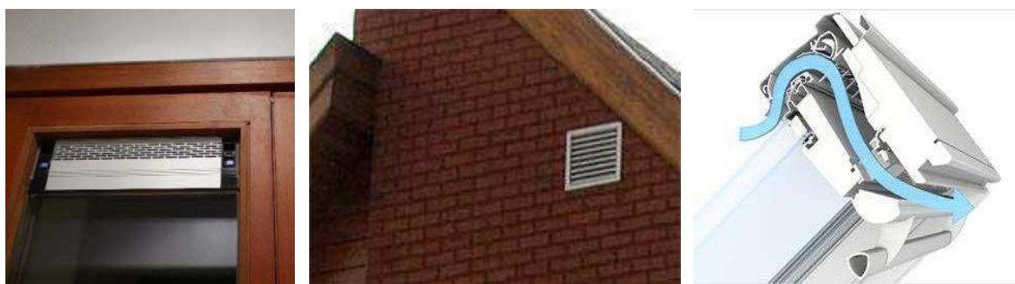
Figuur 3: Toevoerroosters voor natuurlijke toevoer op beglazing, in muur, in raamprofiel
