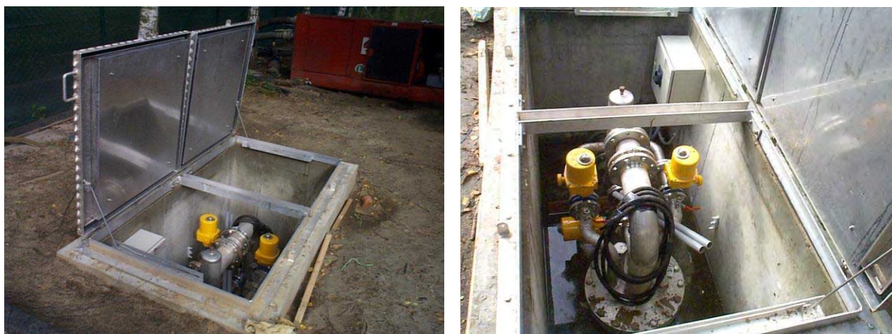
Figuur 44: Collectorput geo-cooling open systeem.
