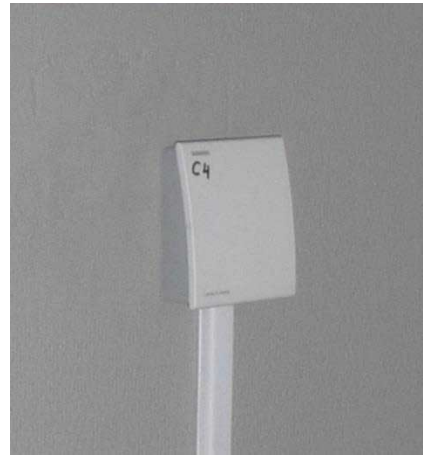
Figuur 62: Voorbeeld van een binnentemperatuursensor
