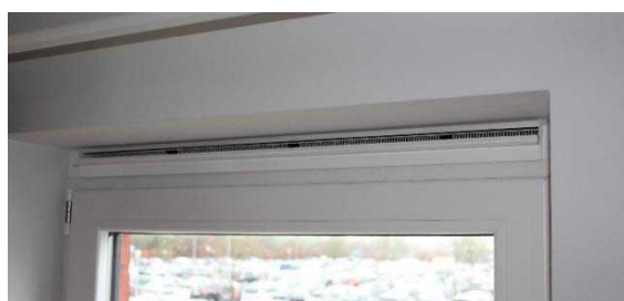
Figuur 47: Regelbare toevoeropening geïntegreerd in raamprofiel
