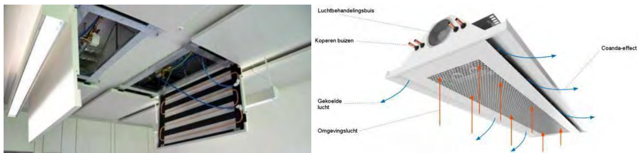
Figuur 66: Koelplafond (links) en koudebalk (rechts)
