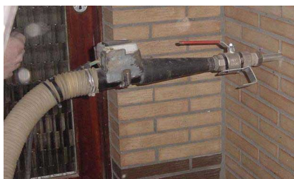
Figuur 100: Plaatsen van na-isolatie
