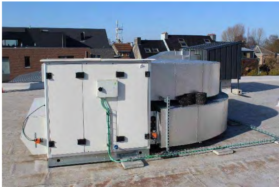
Figuur 45: voorbeelden van mechanische toevoer- en afvoerventilatorgroep
