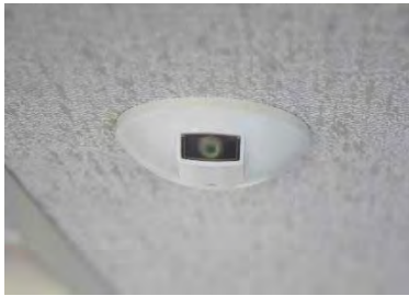
Figuur 91: Daglichtsensor aan het plafond
