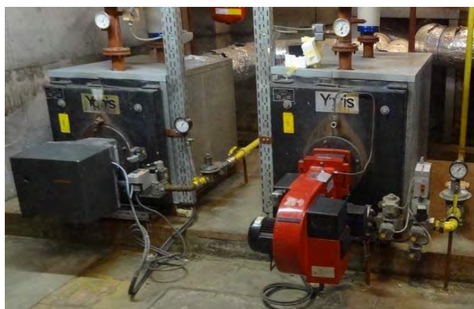
Figuur 31: Voorbeelden van ketels uitgerust met opbouwbranders
