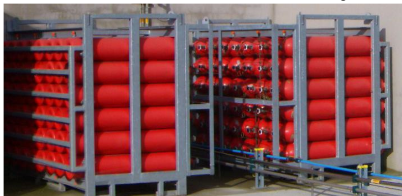
Figuur II.2.4.3: Voorbeeld van een opslag in de vorm van verschillende kaders met gasflessen
