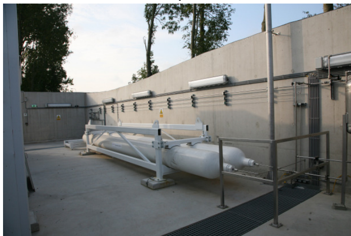
Figuur II.2.6.1: Voorbeeld van de middendruk bufferopslag op het tankstation van te Rhooen
