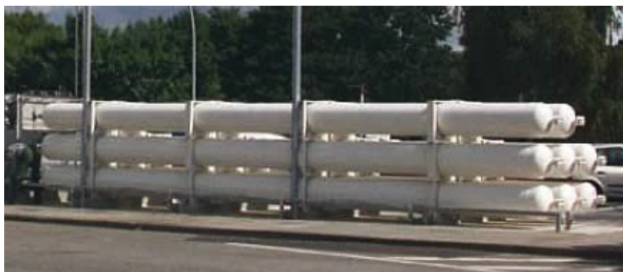
Figuur II.2.4.3: Voorbeeld van een opslag in de vorm van enkele drukcilinders met een volume van meer dan 1.000 liter
