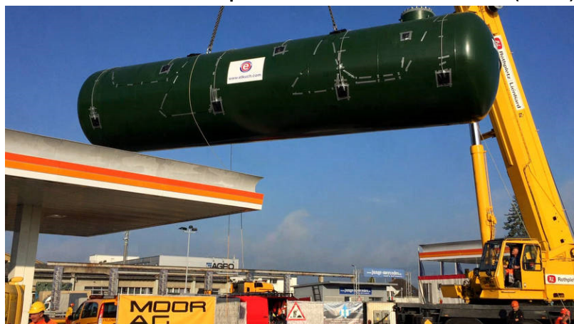
Figuur II.2.4.2: Voorbeeld van een opslag in de vorm van een ondergrondse druktank van 87 m 3 op een tankstation in Hunzenschwil (COOP)
