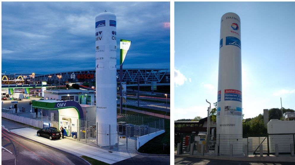
Figuur II.2.4.1: Voorbeeld van een opslag in de vorm van een bovengrondse druktank op een tankstation in Stuttgart (OMV) en in Gieselwind (TOTAL)
