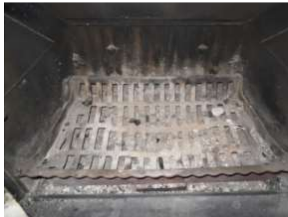
Figuur 22: Voorbeeld van een rooster in de verbrandingskamer van een open haard (Werkspot, 2010)
