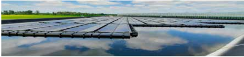
Figuur 9.3: Drijvende zonnepanelen op regenwaterbekken in Hoogstraten. 194
