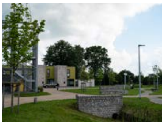
In de Rozenwijk in Kasterlee is de publieke ruimte waar mogelijk onthard en doet ze dienst als waterbuffer
