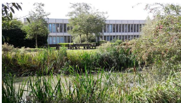
Figuur 15: Achterkant gebouw Oostende
