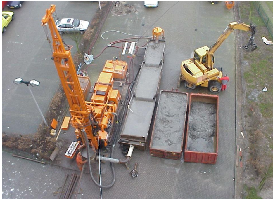
Figuur 8 - Voorbeeld zuigboorinstallatie
