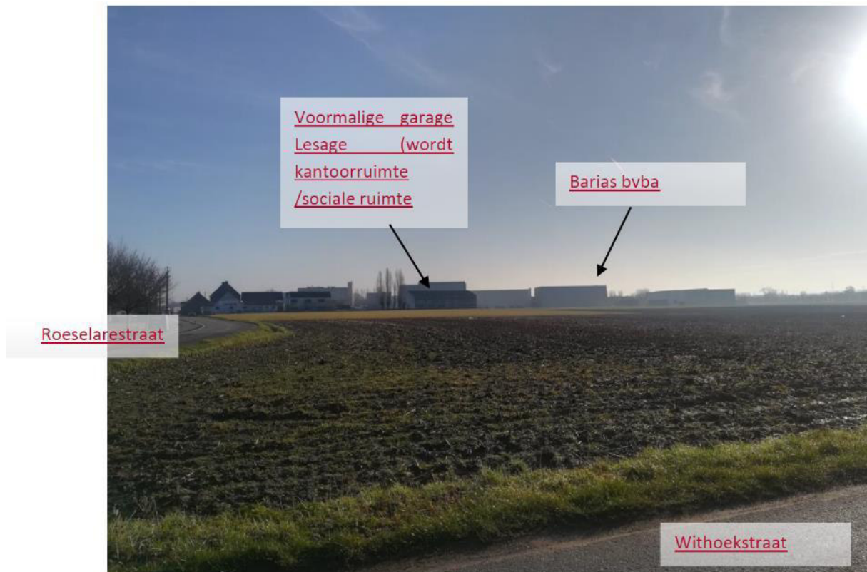
Figuur 45: zicht vanuit de Withoekstraat Roeselarestraat richting Barias
