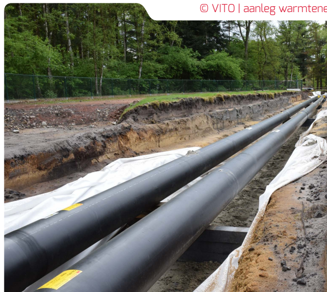
© VITO | aanleg warmtenet
