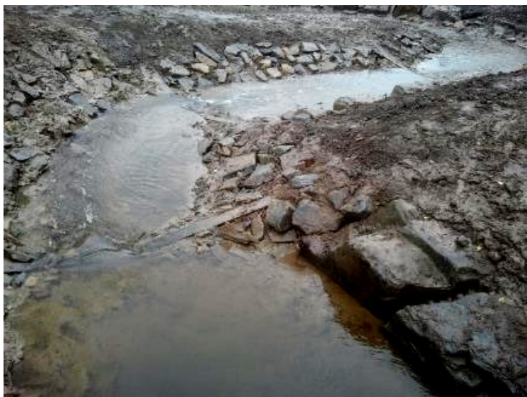
Afbeelding: Voorbeeld bekkentrap Vierlingsbeek (Witteveen+Bos, foto genomen tijdens aanleg)
