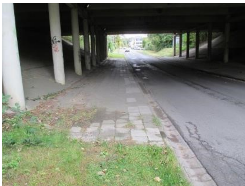
Foto: Viaduct Esdoornenlaan te Overijse
