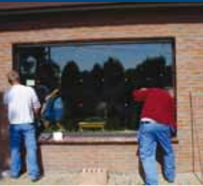
Vervanging van enkel glas door hoogrendementsglas.
