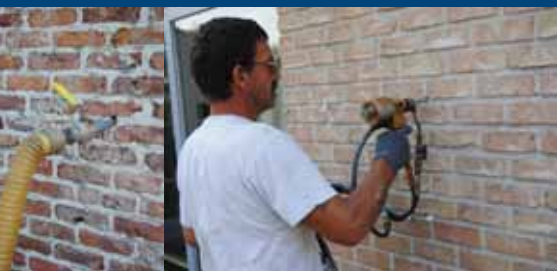
Isolatie inspuiten in de spouw.
