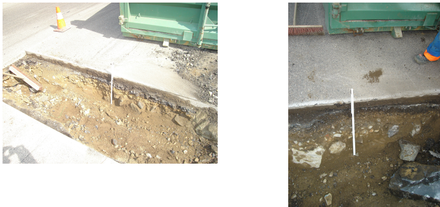
Figuur 3. Foto van een sleuf doorheen een weg om de opbouw van de fundering te kennen.
