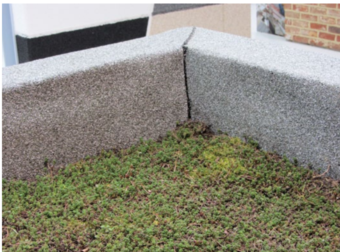
FIG. 61 Een extensief groendak kan, wanneer de technische randvoorwaarden vervuld zijn, aangebracht worden op een monument met een plat dak (foto Nathalie Vernimme)
