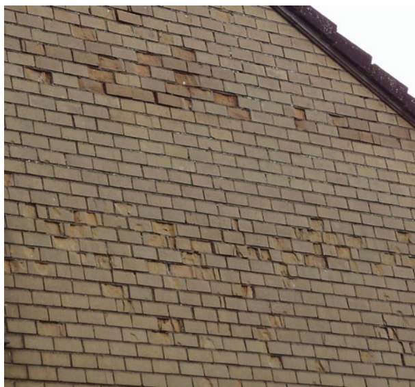
FIG. 66 Vorstschade kan makkelijk optreden wanneer binnenisolatie wordt aangebracht op een gevel met zware regenbelasting (foto Nathalie Vernimme)
