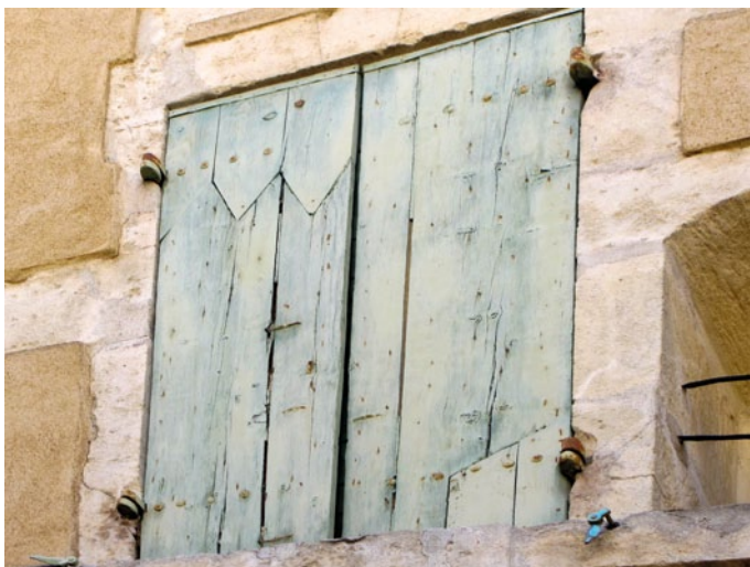
FIG. 21 Plaatselijke herstelling van raamluik (foto Nathalie Vernimme)
