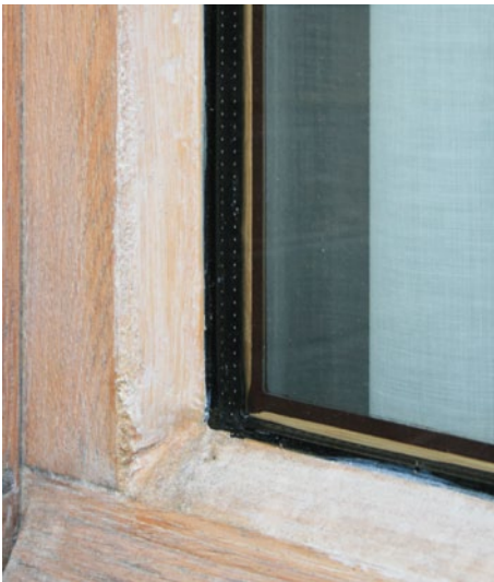
FIG. 83 Detail dubbel glas in bestaand schrijnwerk woning in Lauwe (foto Ann Degunsch)
