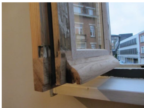
FIG. 73 Kierdichting aangebracht bij een historisch raam (3) (foto's Nathalie Vernimme)
