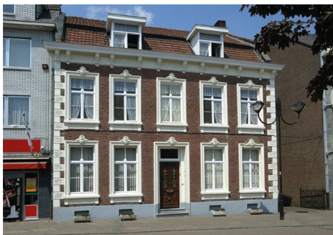
FIG. II Halfopen bebouwing: Huis Spaas, beschermde halfopen bebouwing uit 1885 gelegen in Hamont -Achel (copyright beeldbank Onroerend Erfgoed)
