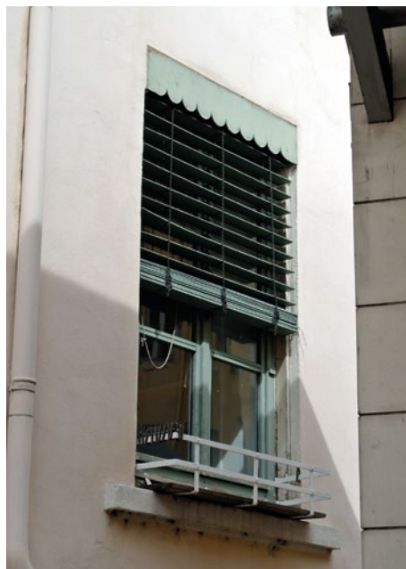
FIG. 101 Venster met buitenzonwering uit horizontale houten lamellen (foto Benoît Delaey)
