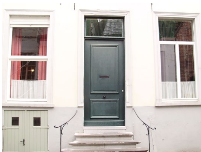
FIG. 68 Woning in de Brugse stadskern: links van de deur het authentieke houten schrijnwerk met oud glas, rechts een standaard pvc-raam met andere profilering en reflecterend float-glas. De erfgoedwaarde van dit pand is er op achteruitgegaan (foto Nathalie Vernimme)
