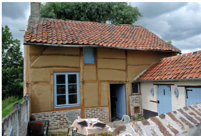
FIG. 16 Vakwerkwoningen, zoals deze in de Koepoortstraat in Zoutleeuw, zijn voornamelijk uit hernieuwbare en/of nagroeibare materialen opgetrokken (foto Benoît Delaey)
