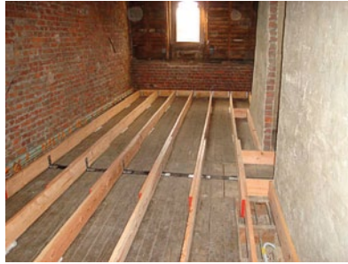
FIG. 58 Isolatie van een zoldervloer. Plaatsen van kepers op de zoldervloer (foto Frederik Mahieu)
