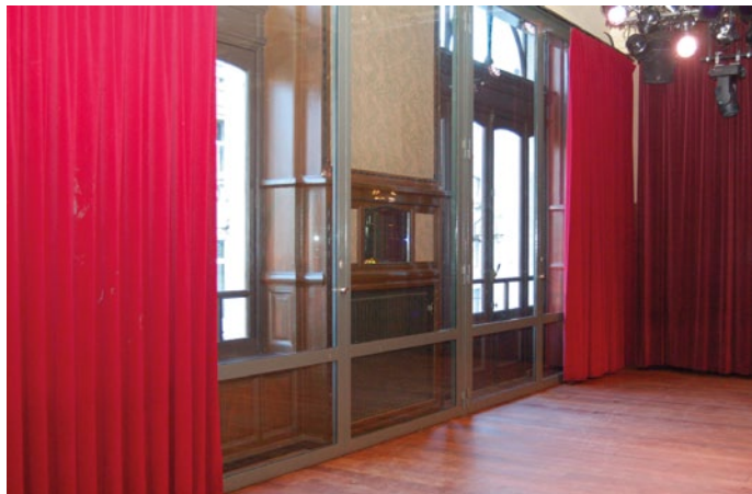
FIG. 78 Een volledige achterzetwand in glas zal in woningen misschien een minder evidente keuze zijn. Op de foto het voorbeeld van de balzaal van de Vooruit in Gent, waar de wand vooral uit akoestische overwegingen is geplaatst (foto Geert Vynckier)
