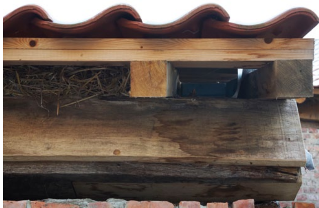
FIG. 52 Detail van het nieuwe dak van de Spikdorenhoeve waarop een lichte verhoging van het dakpakket zichtbaar is (foto Kris Vandevorst)
