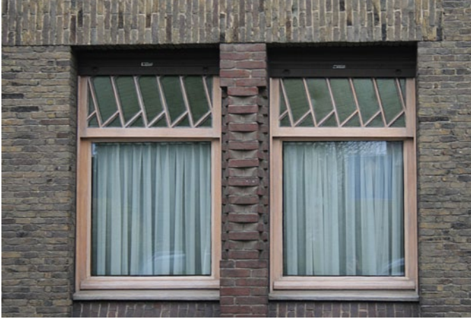
FIG. 83 Detail dubbel glas in bestaand schrijnwerk woning in Lauwe (foto Ann Degunsch)
