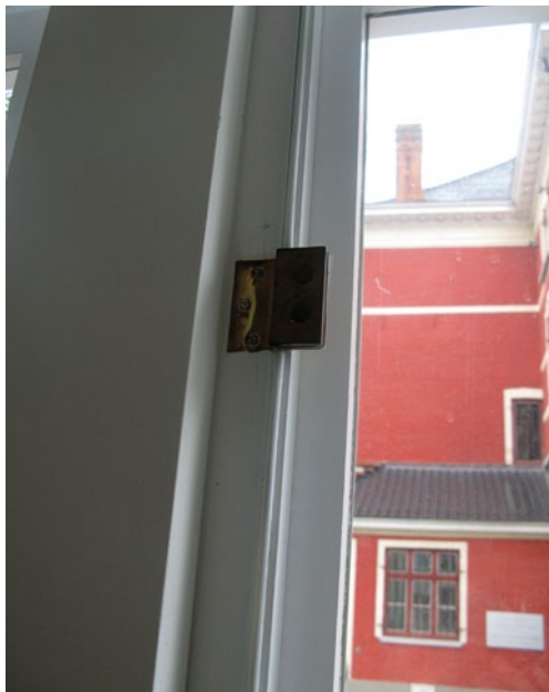
FIG. 8i Detail bevestiging oplegbeglazing met scharnier van woning in de leperstraat in Tielt (foto Ines Deschepper)
