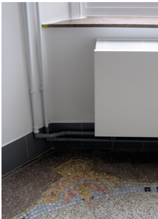
FIG. 22 Het installeren van verwarmingsbuizen in opbouw zorgt ervoor dat deze nadien ook zonder (al te) grote schade terug weggenomen kunnen worden (foto Sara Van Rompaey)
