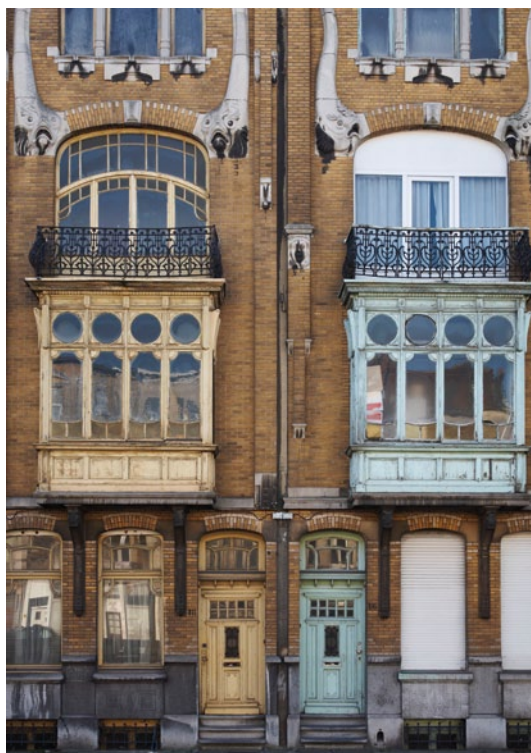
FIG. 70 Een beschermde huizenrij in Antwerpen. Het raam boven de erker van het huis aan de rechterzijde werd vervangen door een raam in een ander materiaal, met andere profilering en zonder respect voor de oorspronkelijke raamverdelingen (foto Kris Vandevorst)
