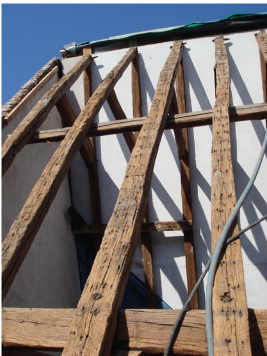
FIG. 50 Plaatsing van dakisolatie aan buitenzijde van de daksporen bij een woning in de Gouden Handstraat in Brugge. Het achterste dakvlak is geïsoleerd, het voorste wordt aangevat (foto Benoit Delaey)
