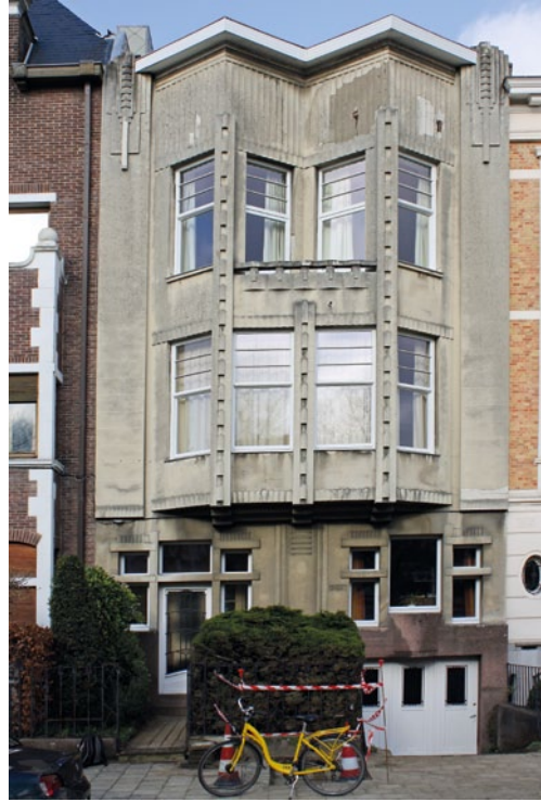
FIG. 90 Reproductie originele ramen voor dezelfde woning in Gent - situatie na de ingreep (foto Halewijn Missiaen)
