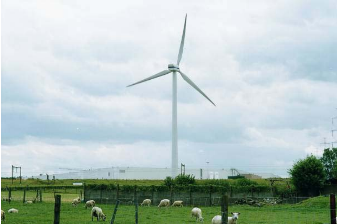
Figuur 2.1: Foto van de windturbine Vestas V66 bij Colruyt, Halle – Dassenveld
