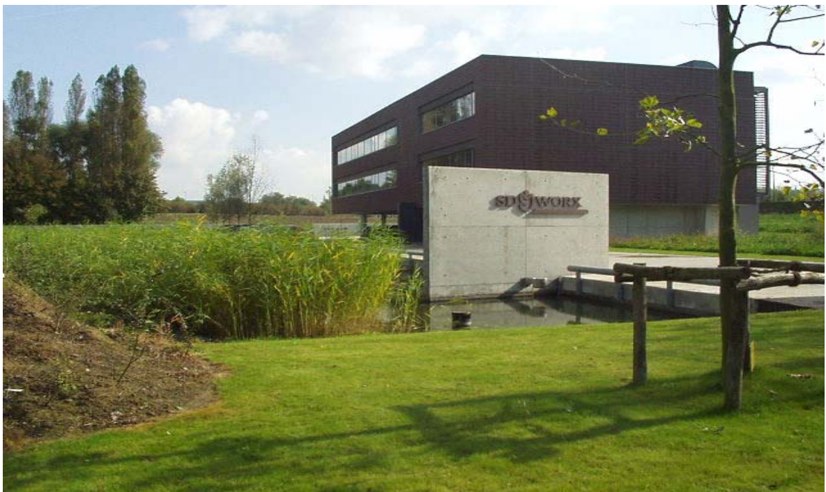
Zicht op het kantoorgebouw SD worx [2]
