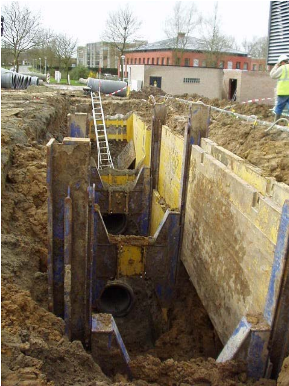
Zicht op de bouwwerken aan de grondbuizen
