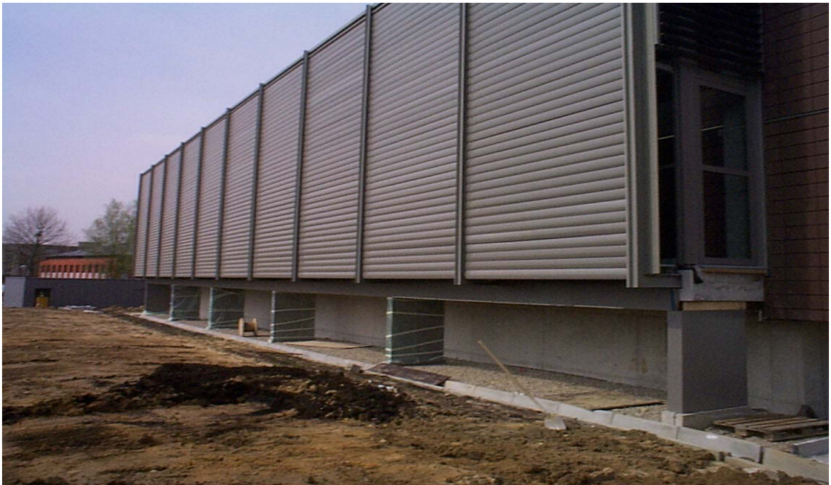
Zicht op de zuid zijde van het gebouw (met gesloten lamellen)
