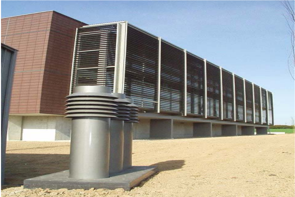
Zicht op het gebouw met open lamellen (op voorzijde de aanzuigroosters van de grondbuizen) [2]
