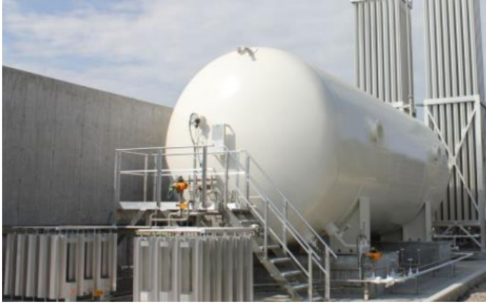
Figuur 16: Vaste installatie voor de bevoorrading van een industriële toepassing met LNG (Cryonorm, s.d.)
