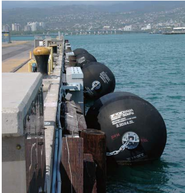
Figuur 23: Drie achter elkaar liggende zwarte fenders uit niet-geleidend materiaal (Yokohama, s.d.)
