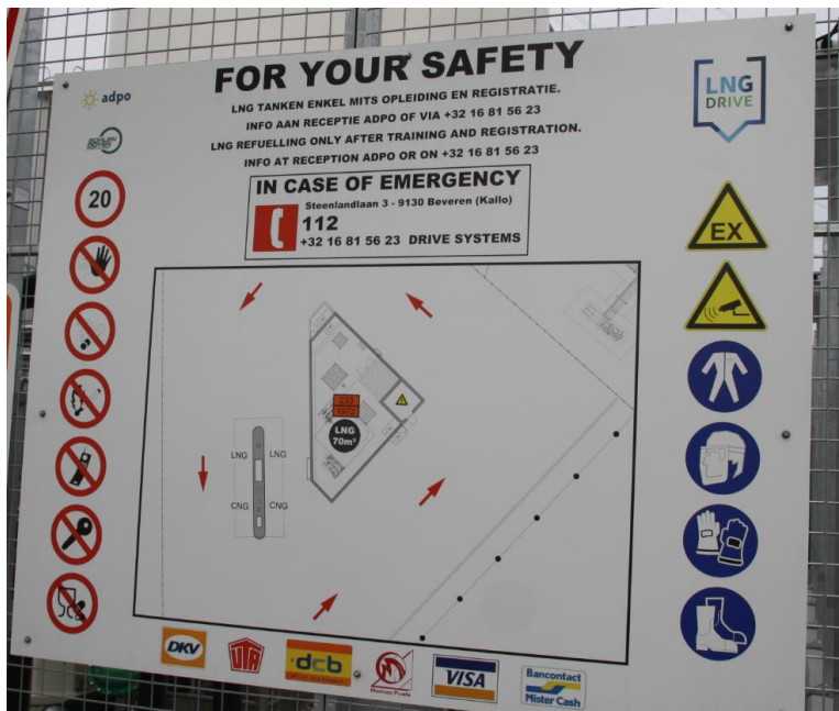
Figuur 33: Signalisatiebord op de afscherming van een LCNG-tankstation (afleverinstallatie voor voertuigen)
