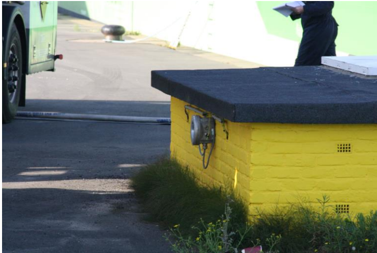
Figuur 24: Aardingspunt voor de LNG-leverende vrachtwagen op de truck-to-ship (TTS) bunkerzone in Antwerpen
