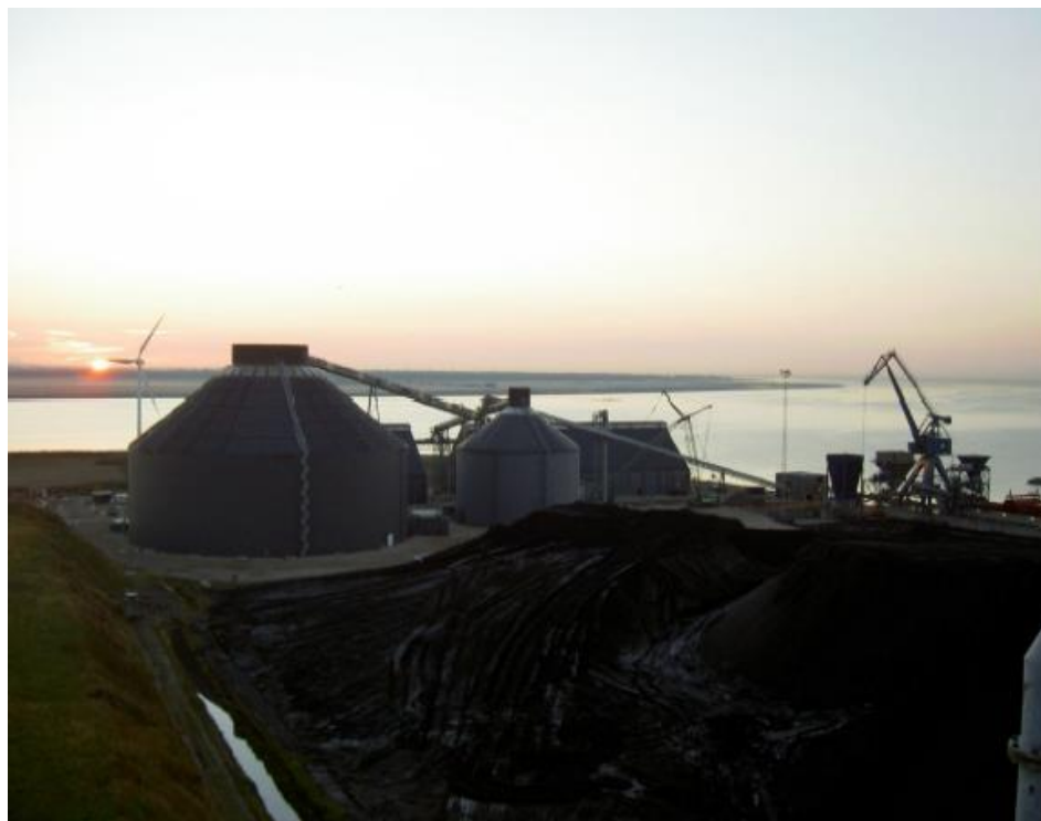
Figuur 4 Logistieke faciliteiten bij Avedore-kolencentrales in Kopenhagen, inclusief een opslag aan 11 kton houtpellets
