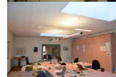
figuur 7 : in dit kantoor hingen oorspronkelijk alleen de naar boven stralende pendlarmaturen. Omdat er niet genoeg licht was, zijn er later armaturen bij geplaatst.
