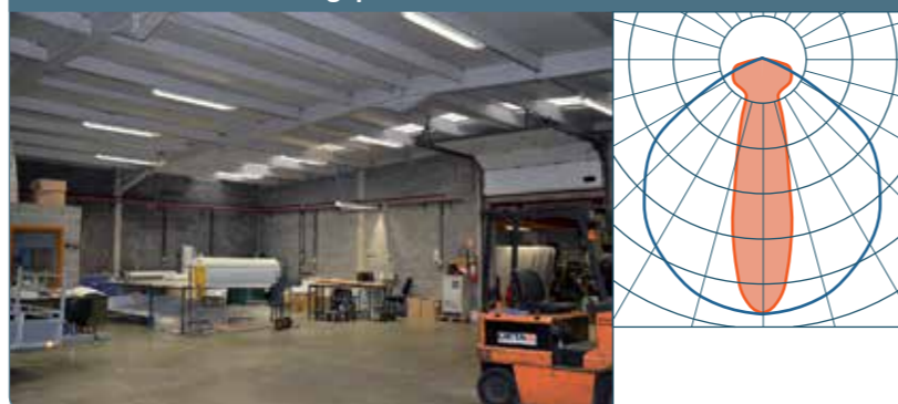
figuur 38 : boven de naaimachine in het midden van de foto is een smalstralende armatuur geplaatst.
