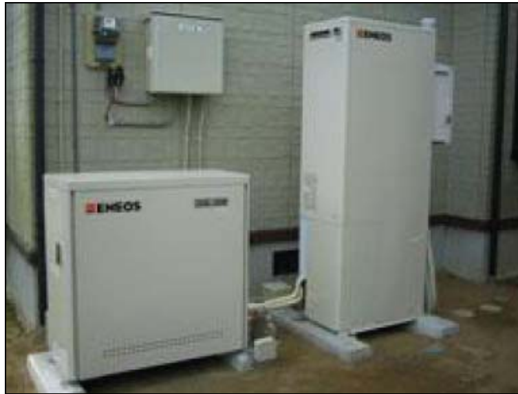
Figuur 5: \mu WKK eenheid obv brandstofcellen (demonstratieproject Japan)
