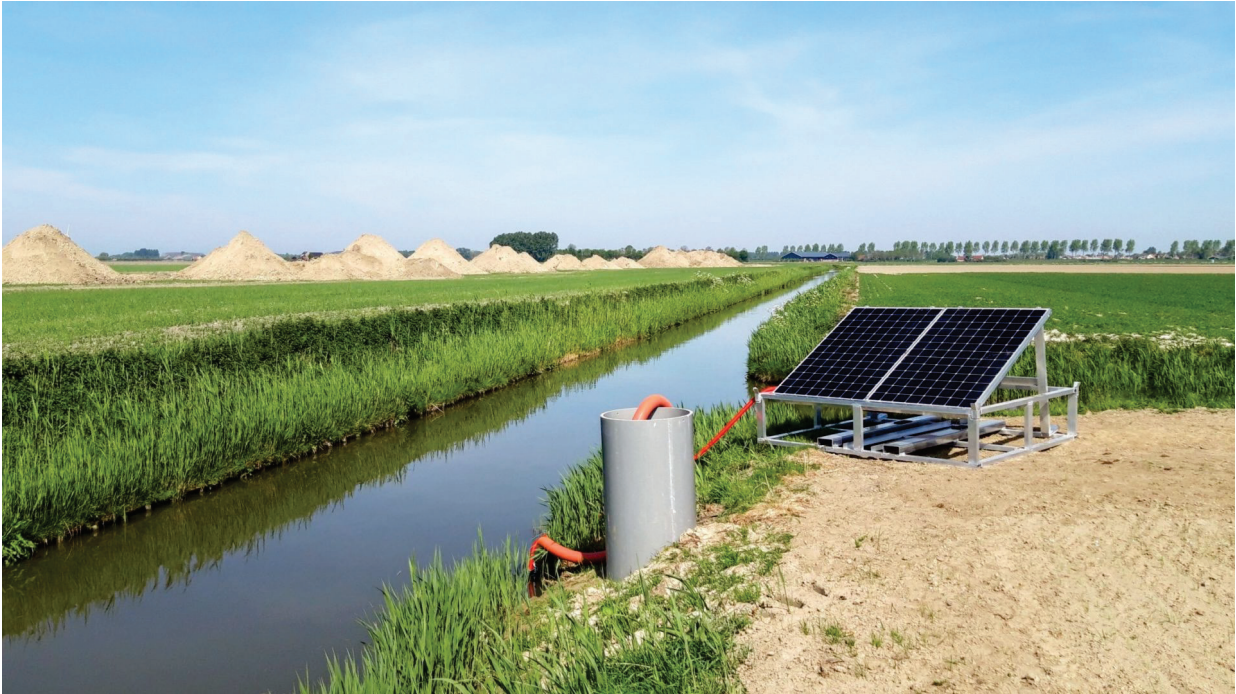
Figuur 30: Illustratie van een zonnepaneel aangedreven pomp met een capaciteit van 600 m 3 /dag (Saman Groep, 2020)
