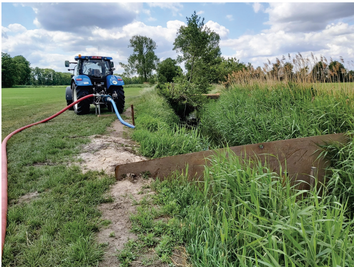
Figuur 25: Onttrekking door het afdammen van een lokale waterloop (Afbeelding van Provincie Antwerpen)
