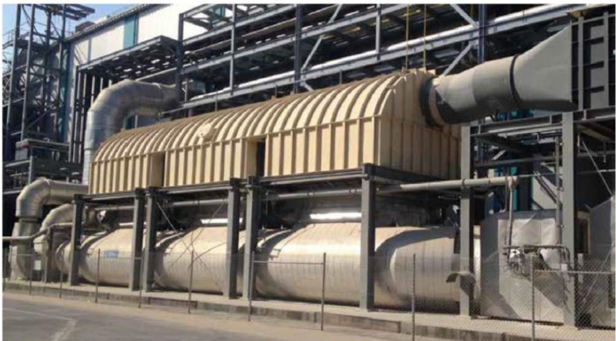
Figuur 35: Afbeelding van een RTO (Bedrijfsfolder Rotamill GmbH)
