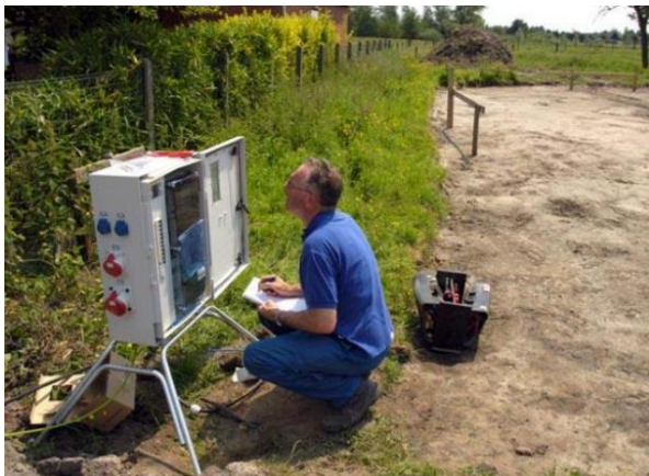
Figuur 24: Werfaansluiting klaar voor gebruik (Eandis, s.d.)
