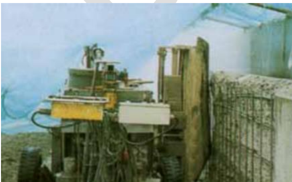
Figuur 35: Waterstraalrobot die brugwand aanpakt (HSE, 1997)
