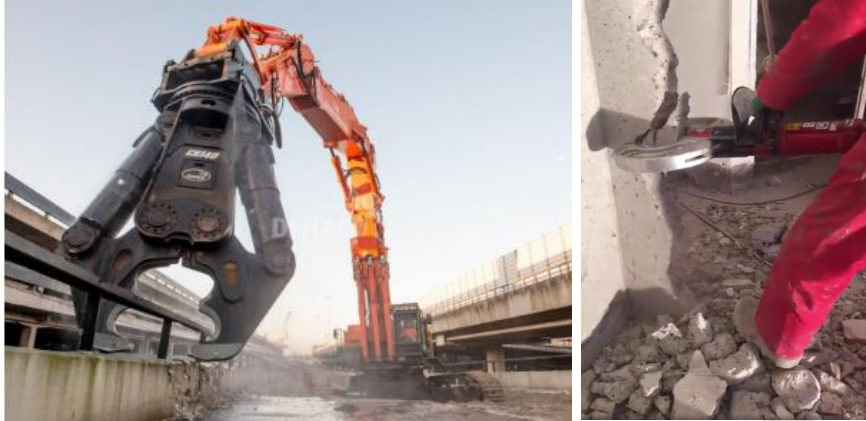
Figuur 31: Hydraulische sloopschaar op kraan (links) (website Dehaco) en hydraulische handsloopschaar (rechts) (LinkedIn Bas Kriesels, 2018)
