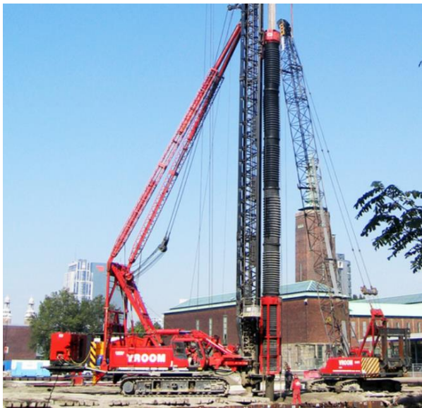
Figuur 28: Harmonicavormige mantels rond de paal (website Vroom Funderingstechnieken en website Dieseko Group)
