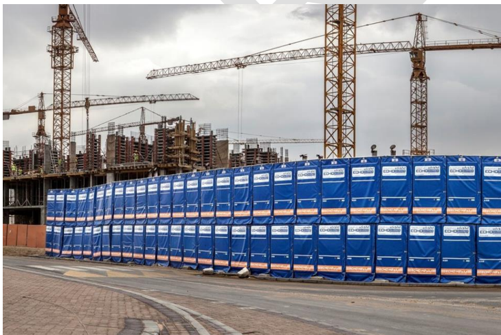
Figuur 20: Geluidswerende schermen rond een werfsite (website Construction News)
