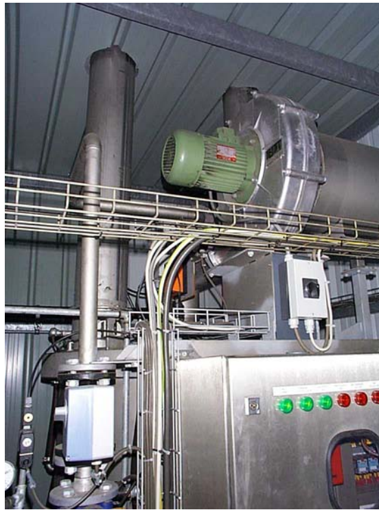
Figuur 2.4: Foto van het bovenste gedeelte van de dompelbrander (biogastoevoer en ventilator)
