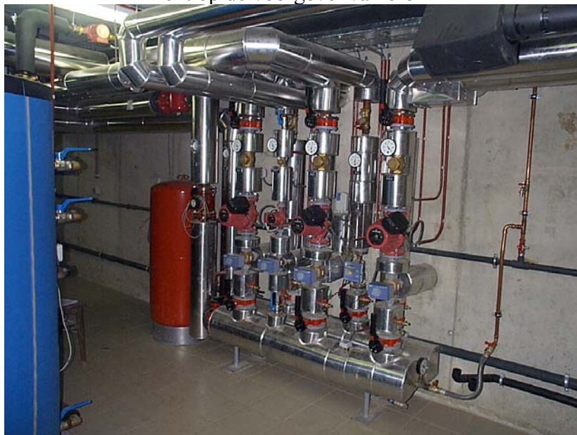
Zicht op de verwarmingskringen
