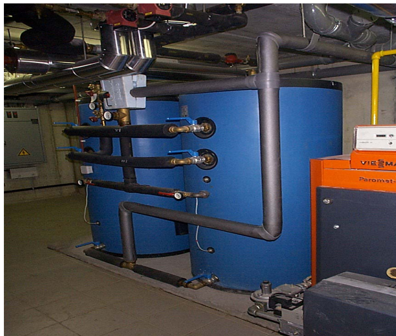
Zicht op 2 buffervaten in de stookplaats
