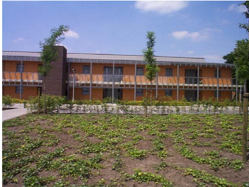
Zicht op de voorgevel van blok 1
