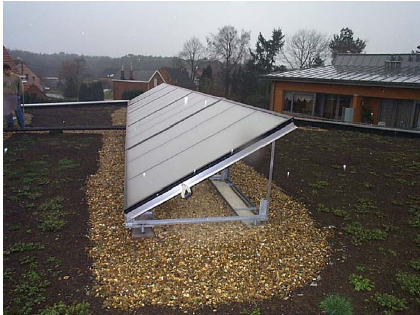
Zicht op zonnepanelen geplaatst op het dak van de ontmoetingsruimte
