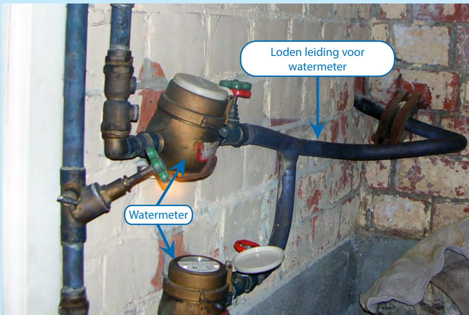
figuur 3: Loden leiding voor watermeter
