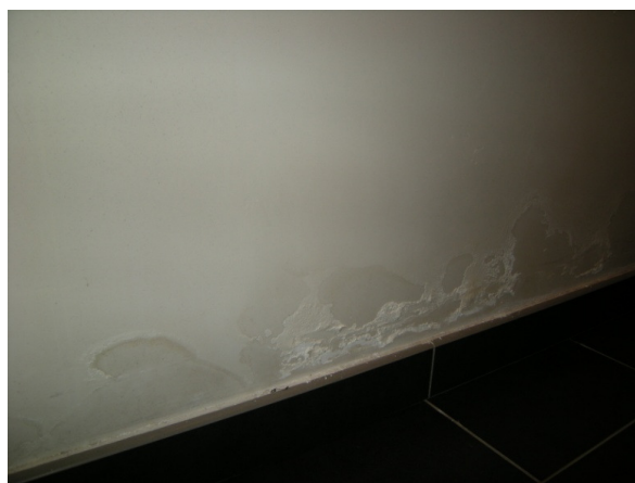
Figuur 16: Loskomen van de binnenbepleistering (boven) en zoutuitbloeiingen op de binnenbepleistering (onder)
