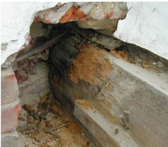
Figuur 19: Schade aan de houten balken ten gevolge van een hoog vochtgehalte op de plaats van de aansluiting met de gevel [Feist 2009]
