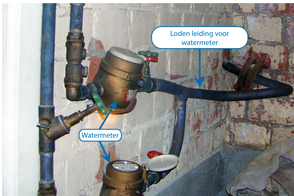
Figuur 3: Loden leiding voor watermeter
